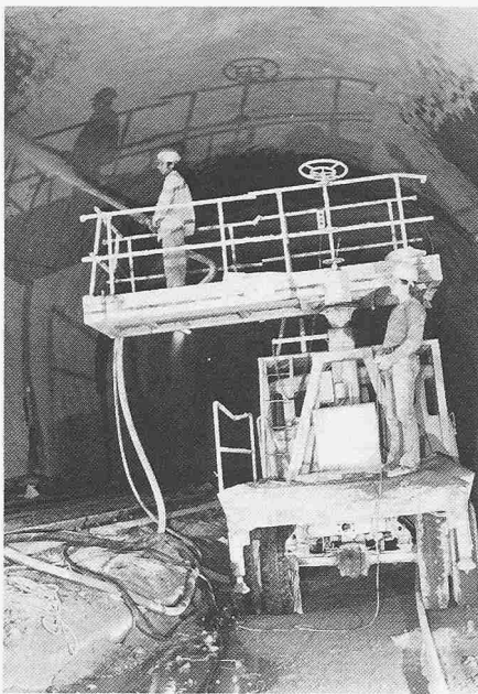
Bild 4. Gespritzt wurde von einem mobilen Gerüst aus mit einer Mischung, bestehend aus 425 kg Hochofenschlackenzement auf 1000 l Sand 0–8 mm. Die Verwendung von Hochofenschlackenzement (75% gemahlene Hochofenschlacke + 25% Portlandzement) war vorgeschrieben. Da verschiedentlich gegen Wasserandrang gekämpft werden musste, wurden je nach Erfordernis Schnellbinder zugegeben. Der «Guniteur» an der Spritzdüse steuerte den Nachschub an Spritzmörtel, Wasser und evtl. Schnellbinder von der Düse aus
