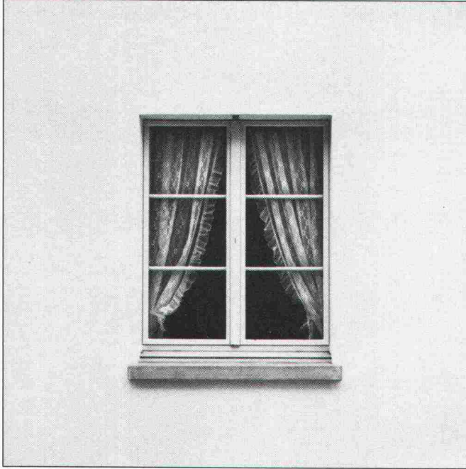
Haus mit aussenisolierter Fassade. Man sieht es.
