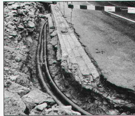
11.55 Komplett verlegt – 360 m nahtlose Fernwärmeleitung – Ziel erreicht!
