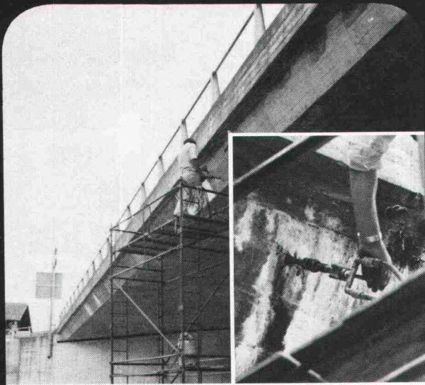
Risse in Betonbauwerken Abdichtung mit Renesco- Flexin-Injektionen
