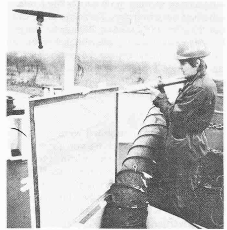
Dichtung einer Fuge zwischen Stahl und eingelegetem elastischem Profil. Der PUR-Kitt wird nicht nur als elastische Dichtung, sondern auch für die Verklebung und Versiegelung in Industrie und Gewerbe verwendet
