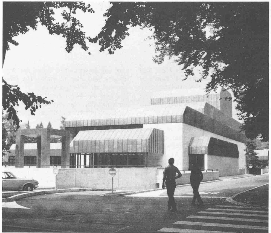
Ansicht von Südosten, Terrasse mit Restaurant
