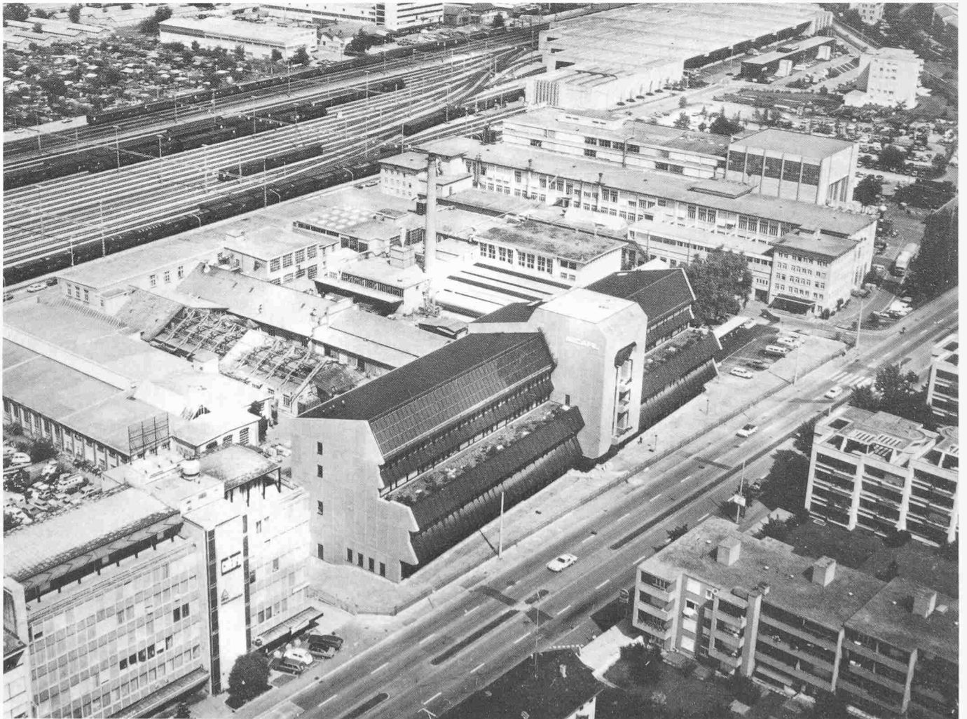
Flugaufnahme der Gesamtanlage von Südwesten
