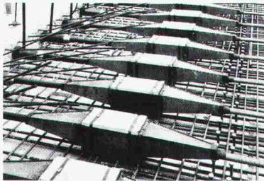
Fahrbahnplatte einer Stahlverbundbrücke mit Zwischenverankerungen Typ Z 630 und festen Kupplungen Typ K<sub>0</sub> 630
