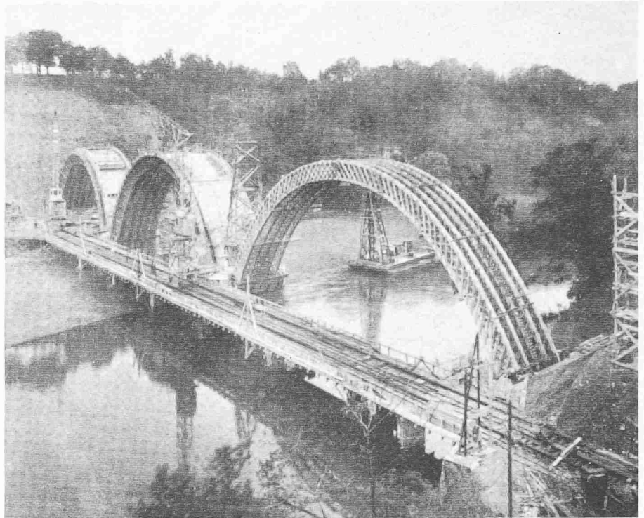
Bild 26. Iehrgerüst des Pont de la Jonction, Genf 1944/45. Stützweiten 57,9-52,3-45,8 m mit verleimten Gurten. Projekt SA Conrad Zschokke und Entreprises réunies Pulver-Olivet zusammen mit Locher & Cie., Zürich [22]
