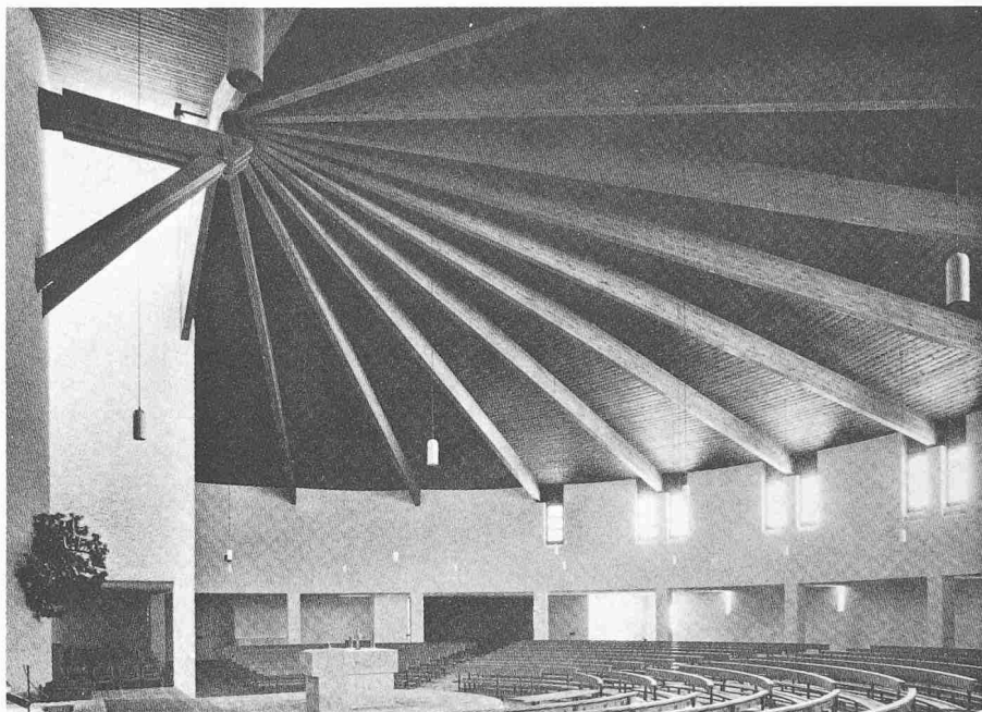
Bild 35. St. Pauluskirche Gossau SG, 1969. Spannweite der Sparren 17,3 m. Architekturbüro Bächtold & Baumgartner, Rorschach. Ingenieurbüro W. Menig, St. Gallen. Holzbaufirma Lehmann AG, Gossau [51]
