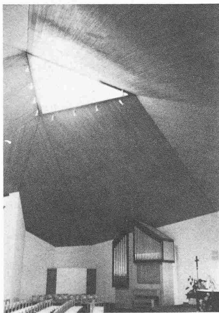
Bild 31. Frei gestaltetes, asymmetrisches Faltwerk in Holz-Leimbauweise als Überdachung der neuen katholischen Kirche in Uitikon, 1970. Architekturbüro D. ErCSI, Uitikon. Ingenieurbüro Dr. H.-H. Gasser, Lungern, und Holzbau AG, Lungern [43]
