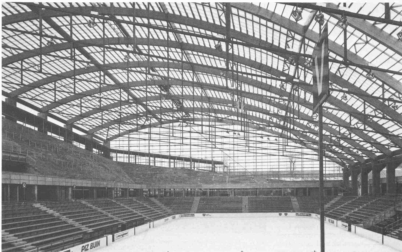
Bild 34. Eisbahnüberdeckung Allmend Bern, 1971. Stützweiten 76–86 m. Architektur W. Schwaar, Mitarbeiter F. Zulauf. Ingenieurbüro Emch & Berger, Bern, Zusammenarbeit mit H. Vogel, Bern. Ausführung und Montage Gribi & Co., Burgdorf, und Häring & Co. AG, Pratteln [39–42]. (Foto LIGNUM)
