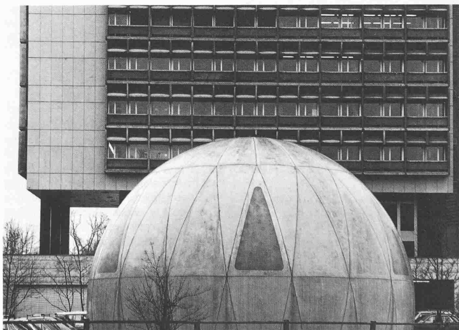
Bild 1. Das 8 m hohe Kugelhaus aus Kunststoff vor der Kulisse des Hochhauses der Abteilung Forschung und Entwicklung PTT in Bern-Ostermündigen
