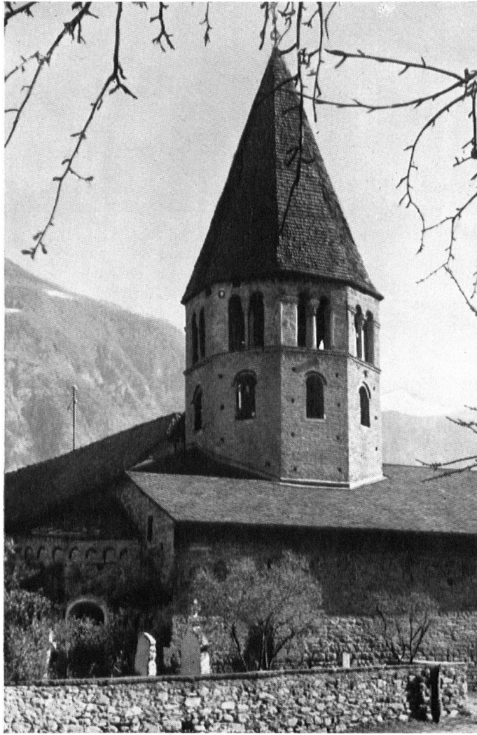
St-Pierre de Clages, das bedeutendste romanische Baudenkmal des Kt. Wallis. Beitrag des Schweizer Heimatschutzes an die Instandstellung: Fr. 10 000.— Einzelheiten siehe im letzten Heft. St-Pierre de Clages est l'édifice roman le plus important du Valais. Une subvention de Fr. 10 000.— est allouée par le Heimatschutz pour le remettre en état. St-Pierre de Clages. Il più importante monumento romanico del canton Vallese. La Lega per il Patrimonio nazionale ne ha sussidiato i restauri con una somma di Fr. 10 000.—. Particolari in proposito nel numero precedente della rivista.
