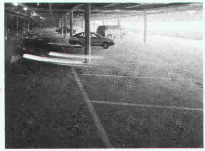
Parkdeck Glattzentrum, Wallisellen
