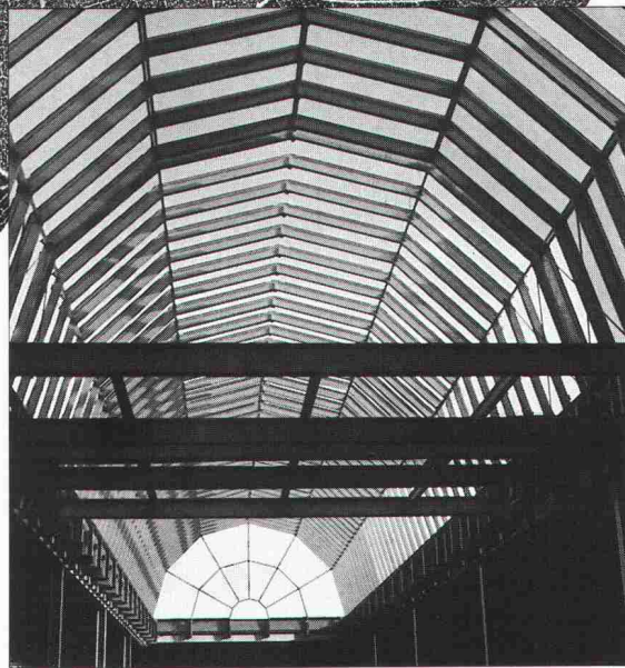
Stahl- und Industriebau
