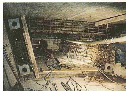
Bild 13. Verstärkung Überbau, Armierung Vorspannung Bildautor: A. von Glutz
