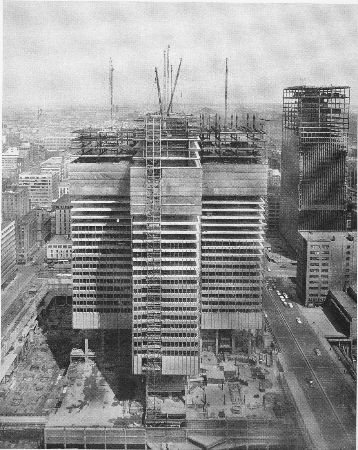
Fig. 15. Vue du projet en avril 1961, montrant la progression de l'érection et la disposition des derricks
