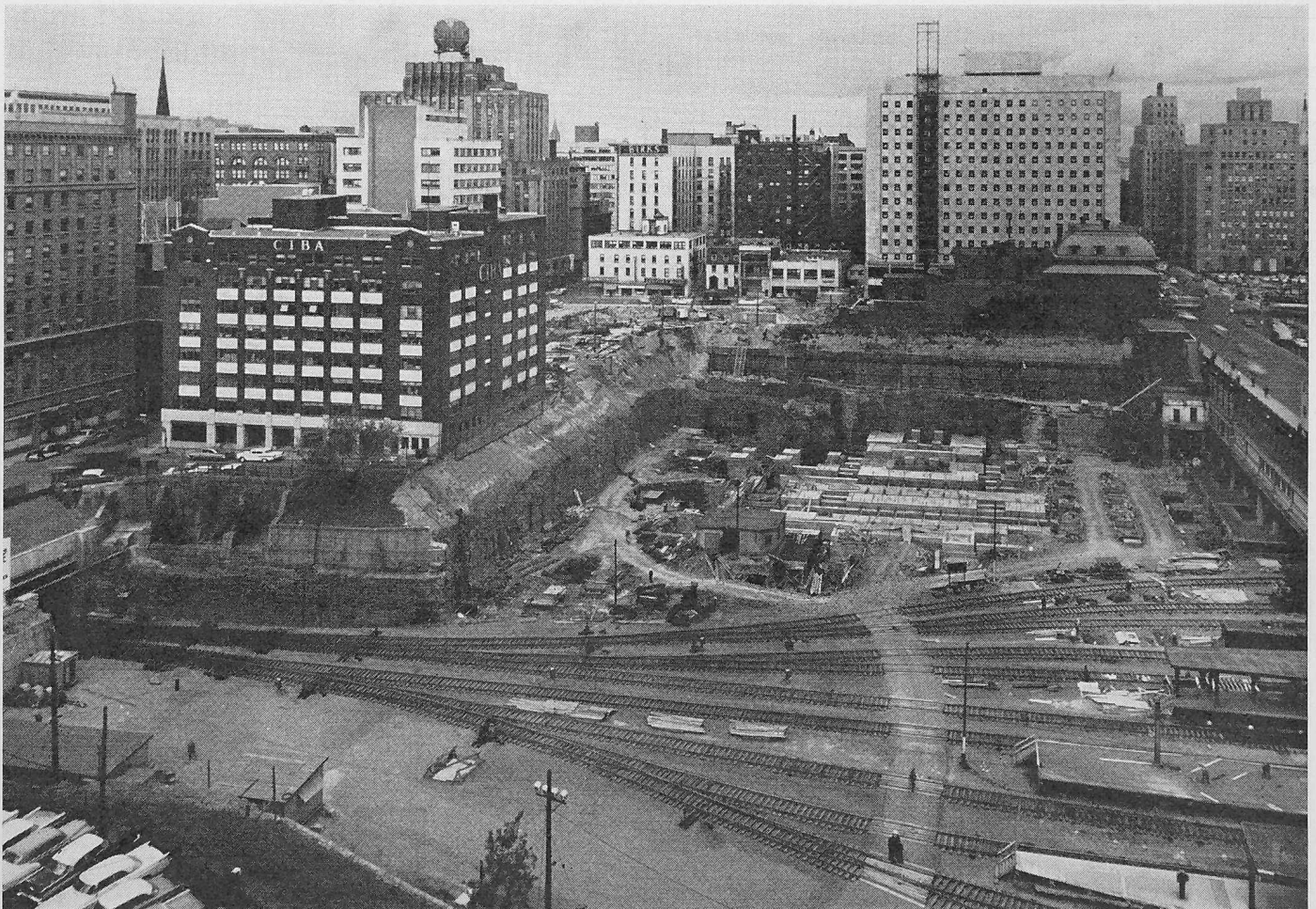
Fig. 2. Vue du chantier au début de la construction (septembre 1959). On peut encore y voir le bâtiment CIBA et, dans le fond, le Club St. James. Ces deux bâtiments ont été démolis plus tard
