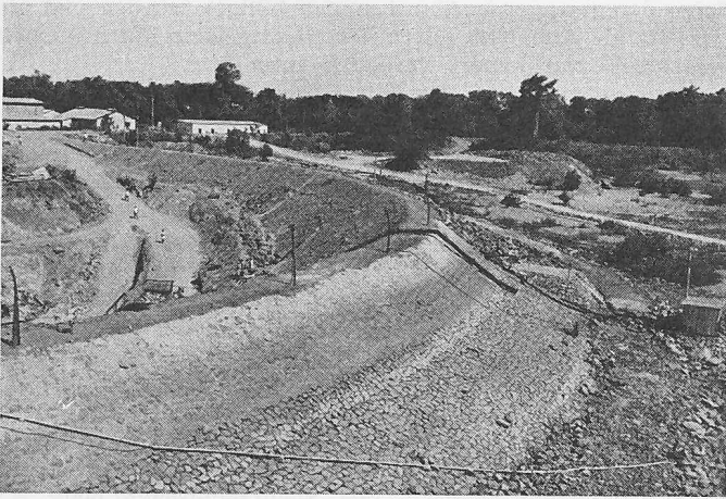
Bild 10. Unterwasserseitiger Fangdamm während der Niederwasserperiode im April 1961
