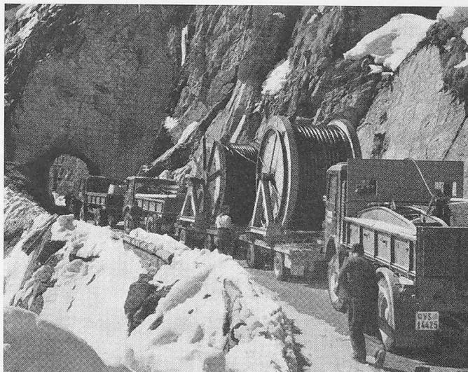
Fig. 3. Transport du câble pour blondins entre Grimentz et Moiry le 5 avril 1956
