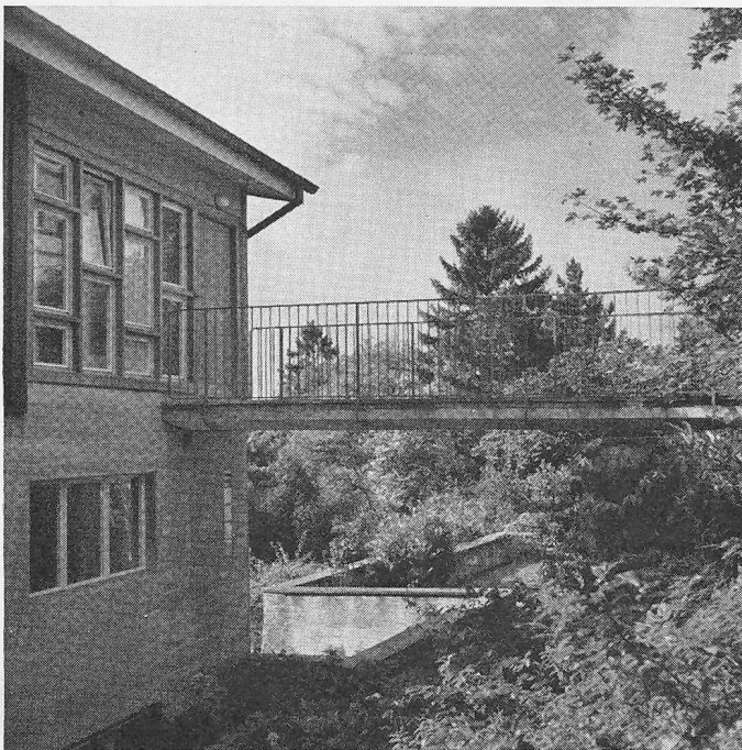
Passerelle zum Hauseingang (0,00)
