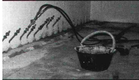
Elastische Abdichtungs-Injektion-Rascoflex in einer Zivilschutzanlage.
