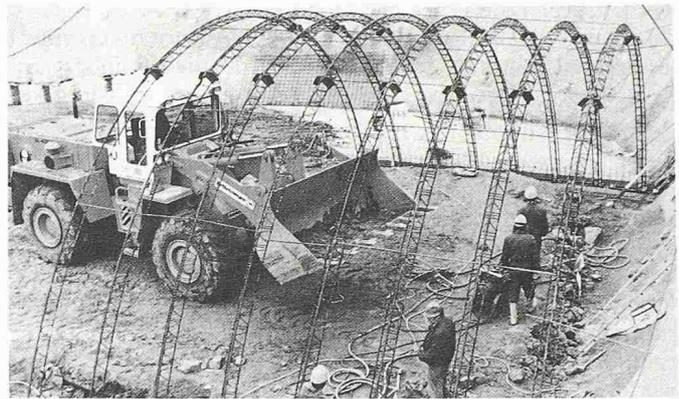
Bild 3. Herkömmlicher Übergang Tunnelinnenschale (links) zum Portalbauwerk (rechts) (Eber)
