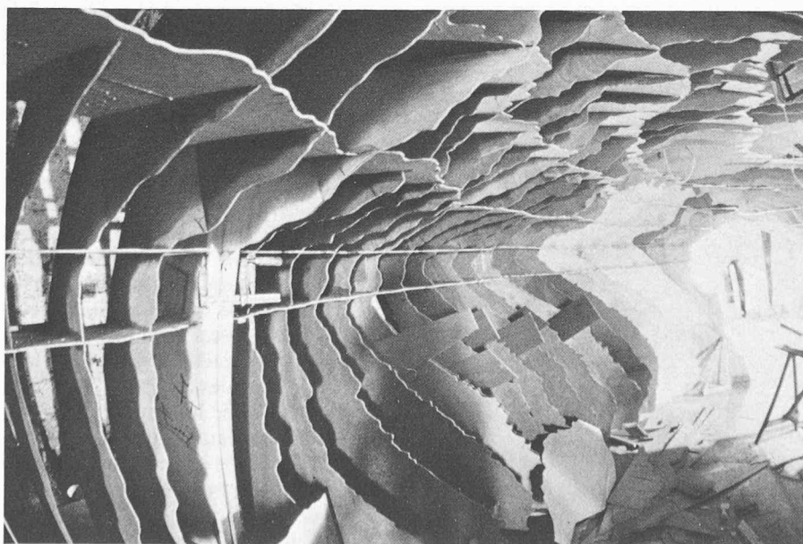
Réalisation et assemblage des couples en contre-plaqué constituant l'ossature de la reconstitution de la grotte de Lascaux. Atelier «Unité Théâtrale et Recherche» à Lyon — juillet 1980.
