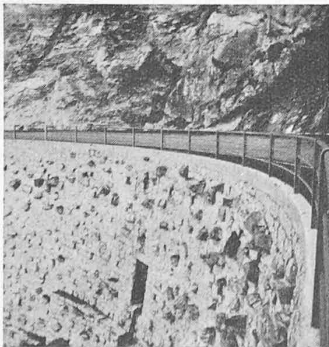
Abb. 3. Gegenbeispiel: Schichtenmauerwerk mit vorstehenden Spitzbossen
