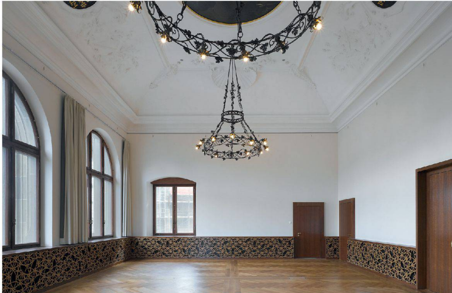
10 Musiksaal nach der Sanierung: Der Parkettboden weist neu eine Gliederung auf, das umlaufende Bord verbirgt die nötigen technischen Installationen (Foto: Roger Frei)
