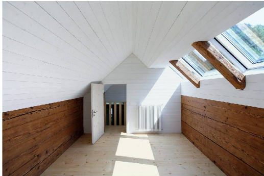
Die neu ausgebaute Dachstube im Haus Balmermatte in Uri. In den ehemaligen Lager- und Trockenräumen im Estrich wurde zusätzlicher Wohnraum für eine Familie geschaffen (Foto: André Hergler)
