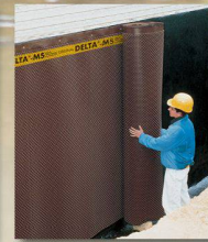
DELTA-MS Sauberkeitsschicht, Grundmauerschutz und Sickerschicht
