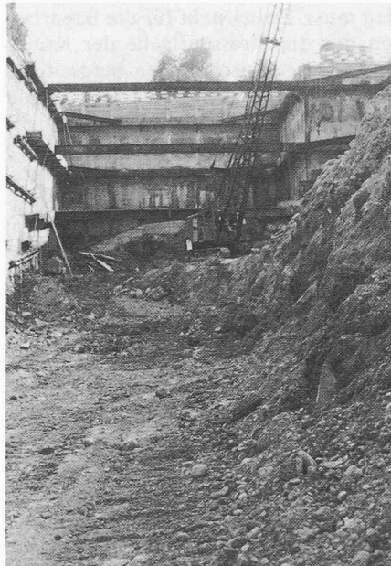
Bild 10. Portalbaugrube Seite Stettbach
