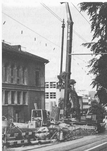
Bild 5. Kreuzbühlstrasse, Herstellung schrägpfähle vor dem Haus Nr. 26
