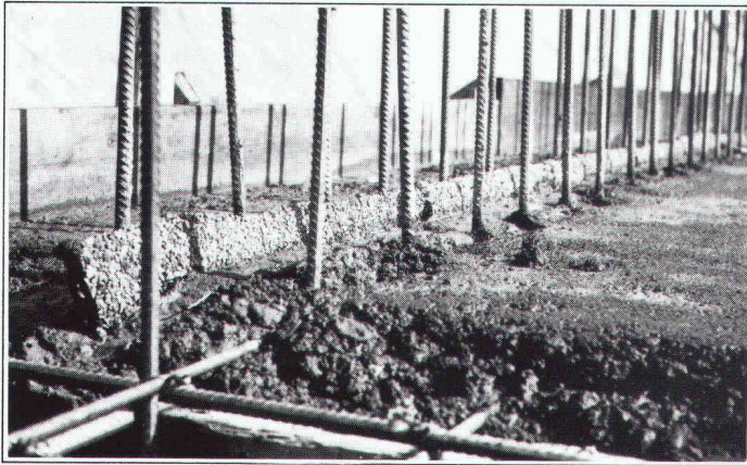
Erstellen einer Anschluss-Dichtung "BFL-MASTIX" Typ 20/70 R4.
