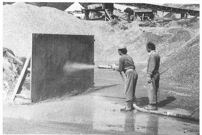
Bild 8. Einspritzen einer Holz wand mit Stahlfaserspritzbeton an der Demonstration vom 29. Juni 1982
