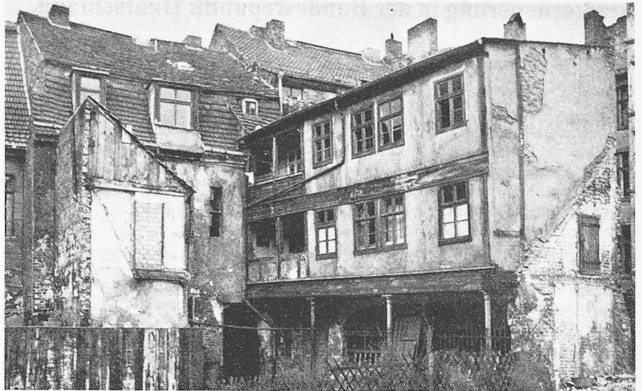
Hof an der Fischerstrasse, vor dem Abbruch
