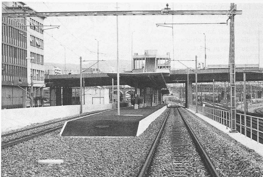
Bild 6. Blick auf die neue Haltestelle «Hardbrücke»
