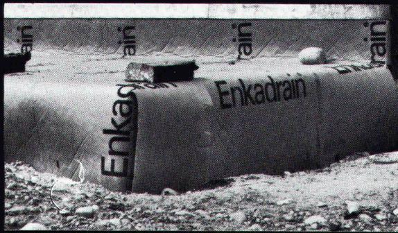
Beispiel einer auf- und abgekanteten Verlegung
