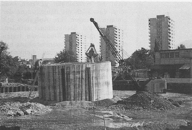
Bild 5. Zugpfähle vor dem Einbau
