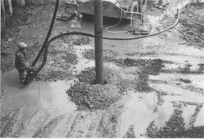
Bild 6. Rüttelverdichtung
