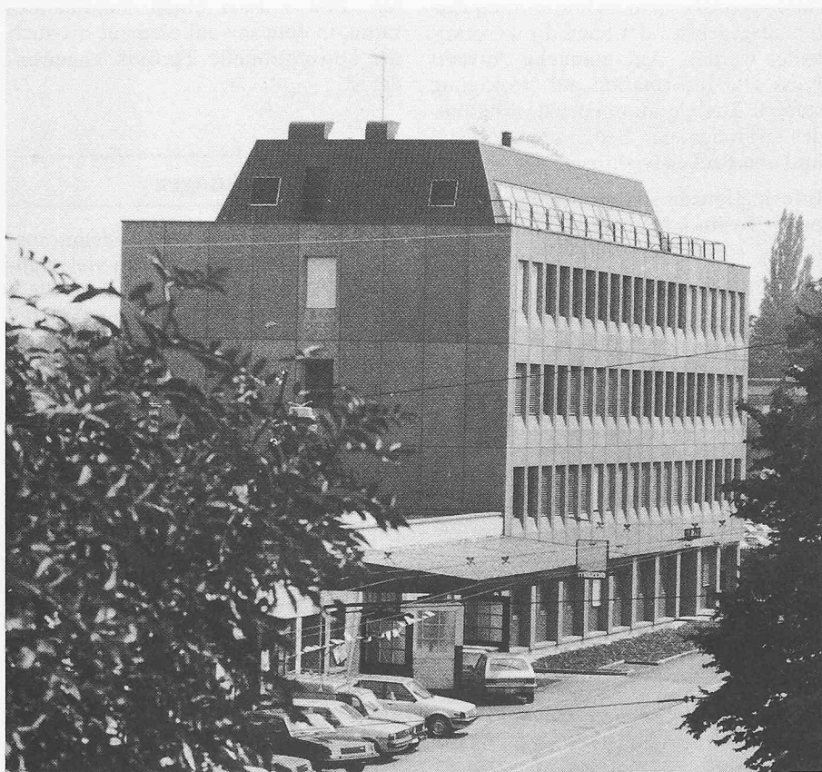
Bild 1. Aussenansicht des Bürotraktes. Sonnenkollektoren in Dach integriert
