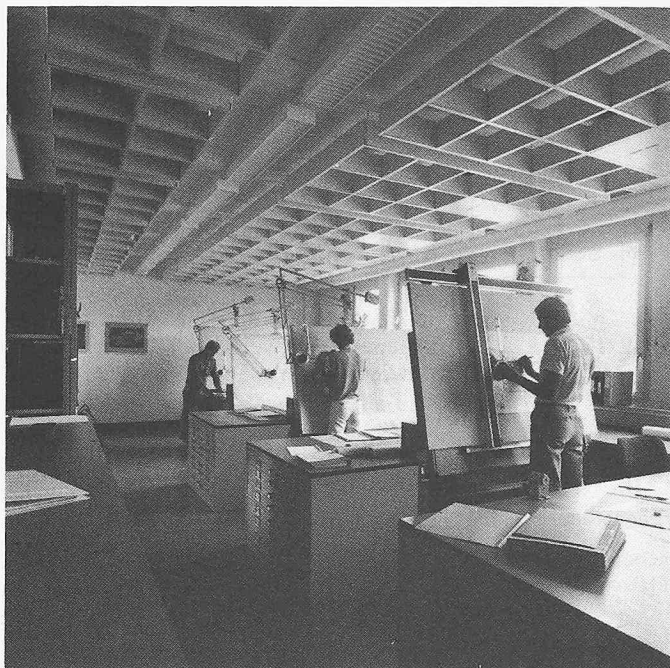
Bild 2. Büro mit Sichtmontage der haustechnischen Installationen. Luftfein-führung über Schlitzplatten
