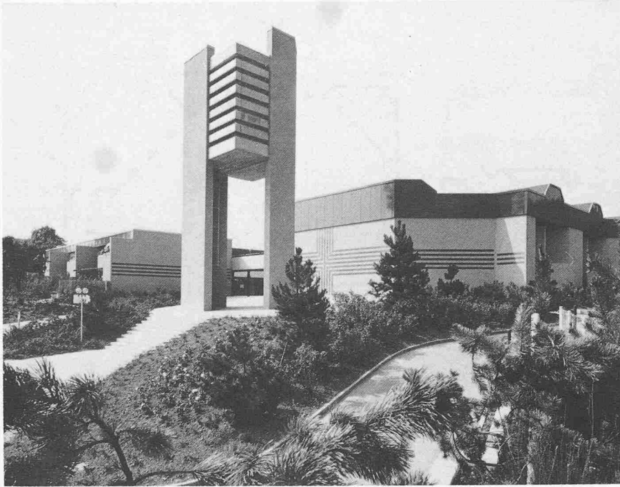
Ansicht von Südosten. Links der Wohntrakt, rechts der Versammlungsakt
