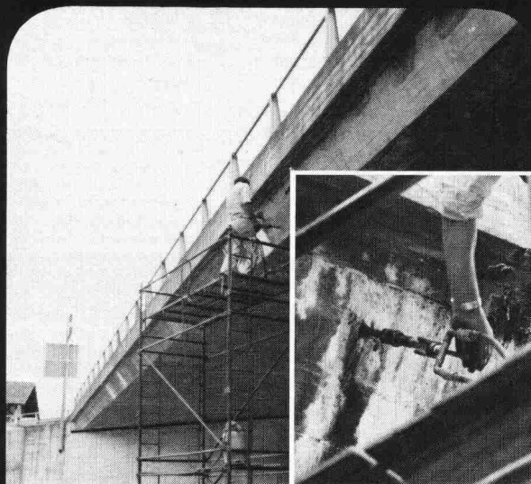
Risse in Betonbauwerken Abdichtung mit Renesco-Flexin-Injektionen
