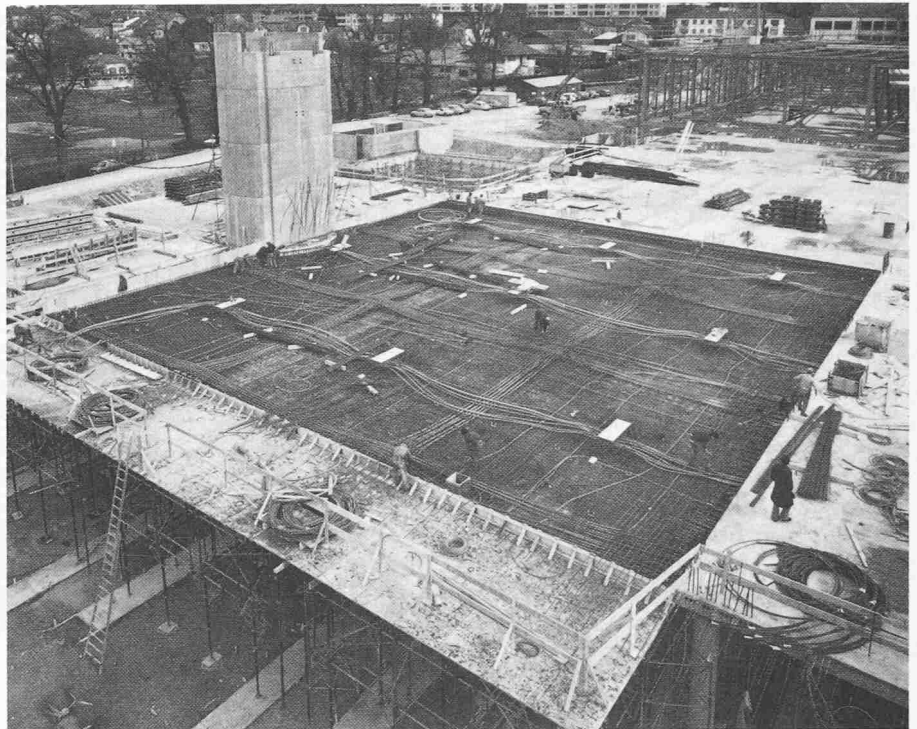
Bild 11. Palais des Expositions, Genf, 1979 (obere Bewehrung noch nicht verlegt)
