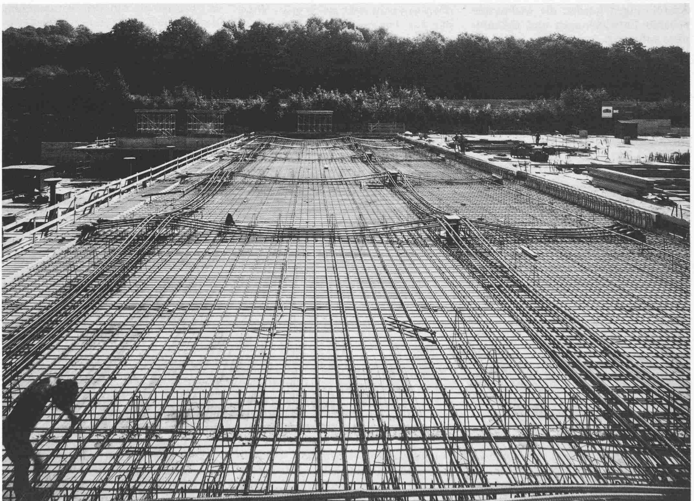
Bild 1. Stützstreifen-Vorspannung (obere Bewehrung noch nicht verlegt)
