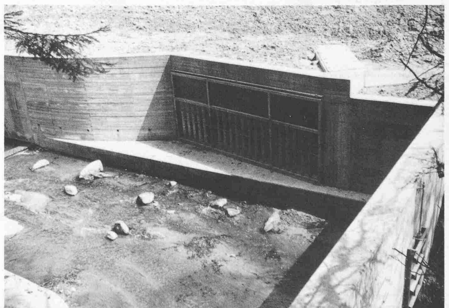
Bild 6. Einlaufbauwerk mit Überlaufschwelle und Rechen
