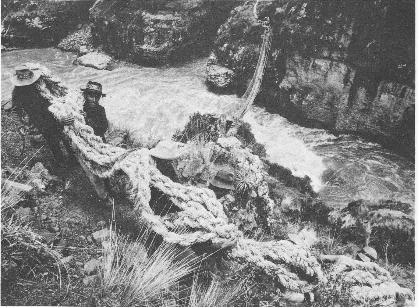
Transport des Kabels zum Bauplatz
