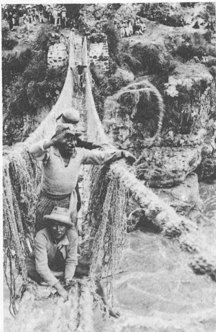
Fertigstellung von Geländer und Boden
