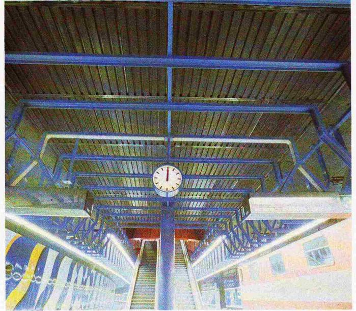
Bild 4. Rippenkonstruktion über dem Perrongeschoss
