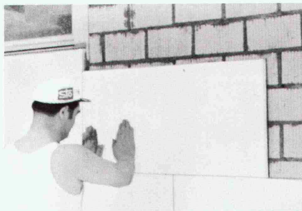
System K: Hartschaumplatten vesetzt auf Mauerwerk kleben.
