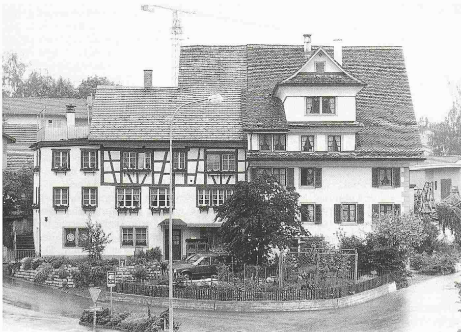
Seit 1981 statistisch belegt: Der Trend «aufs Land» hält an. Die Wohnbevölkerung in ländlichen Gemeinden wächst deutlich stärker als in den Städten. Sicherlich trägt dazu bei, dass in diesen Gemeinden immer mehr Wohnraum durch Umnutzungen und Sanierungen geschaffen wird (Bild: Comet)
