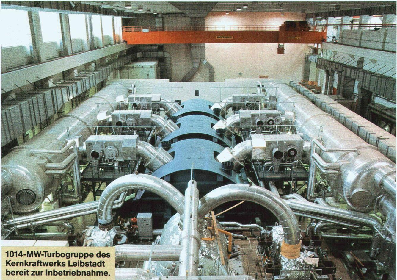
**1014-MW-Turbogruppe des Kernkraftwerks Leibstadt bereit zur Inbetriebnahme.**
