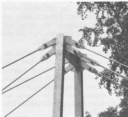
Bild 6. Pylonkopf mit Anschluss der Zugstangen
