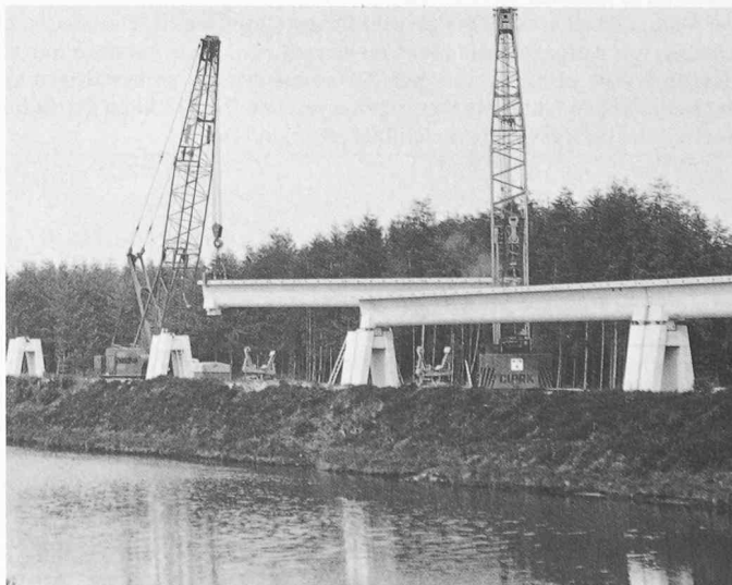
Bild 3. Verlegen der 25 m langen Spannbetonfertigteile für den Betonfahrweg (Bild 2)
