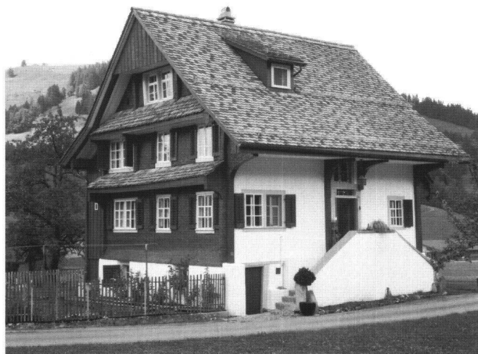
Abb. 4: Rothenthurm, Kaplanei Biberegg. Wegen des Verputzes auf der Eingangsseite lehnt sich das in Holz erbaute Haus in seiner Gestaltung an ein Bürgerhaus an.
