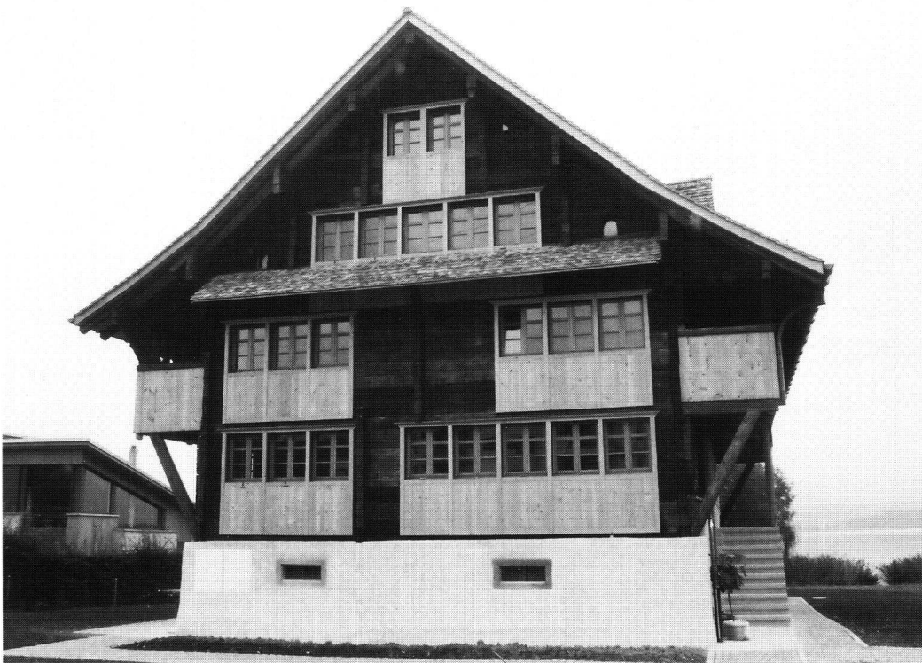
Abb. 7: Altendorf, Haus Steinegger, Hafengeweg 2. Die Hauptfassade präsentiert sich im Zustand mit den Veränderungen des 18. Jahrhunderts mit neuen Lauben und Ziehläden. Bei diesem Umbau war die Fensteranordnung des 16. Jahrhunderts unverändert übernommen worden.
