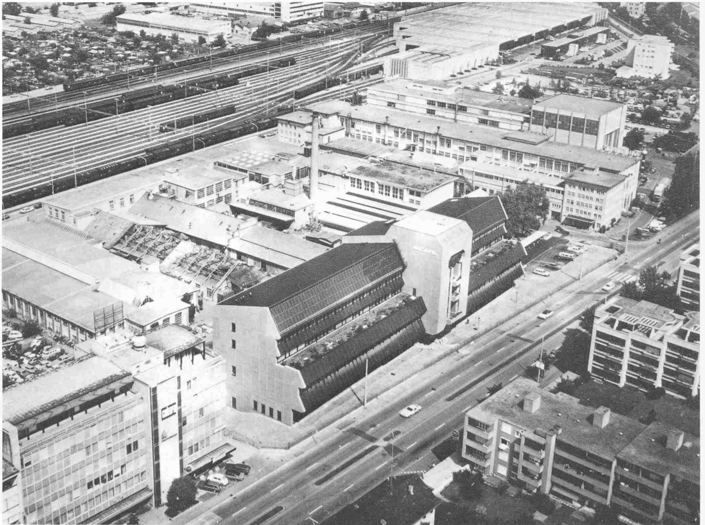
Flugaufnahme der Gesamtanlage von Südwesten
