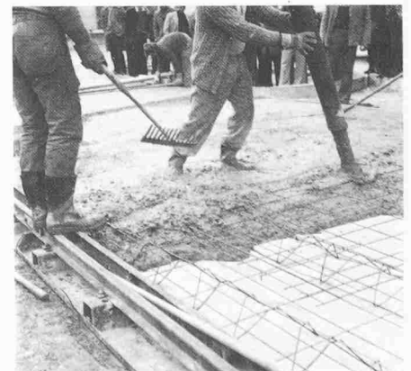
Bild 6-8. Eine ungeeignete Zusammensetzung (Sieblinie) des Ausgangsbetons lässt sich nicht kompensieren durch eine höhere Dosierung des Zusatzmittels!
