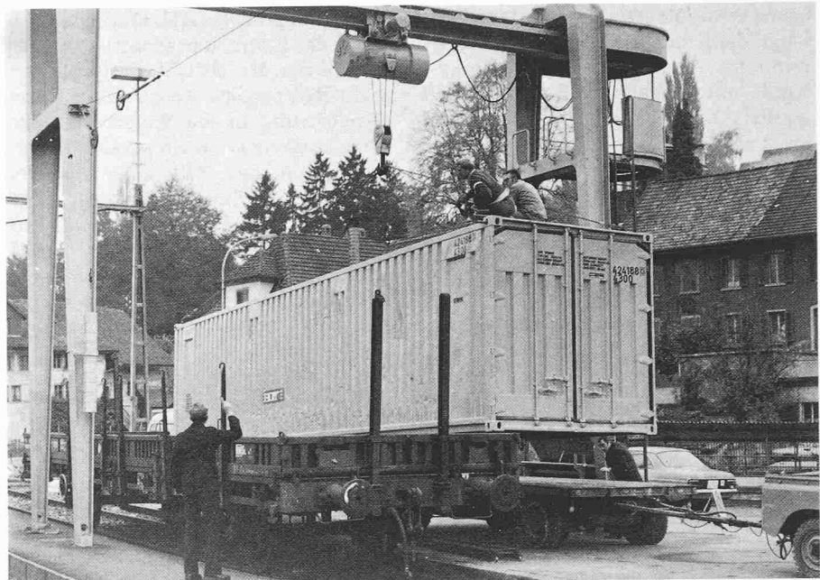
Bild 2. Verlad des Containers
