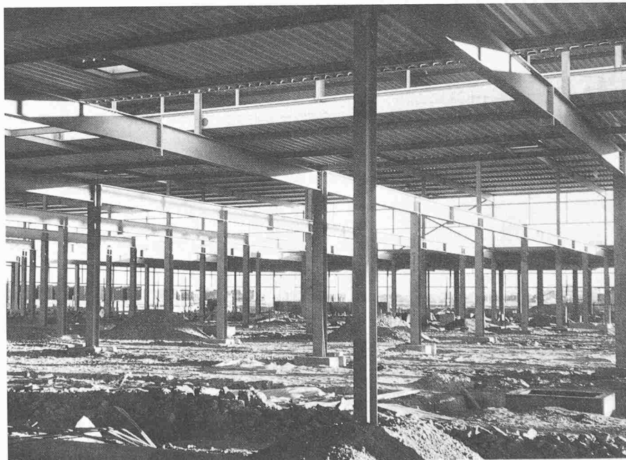
Innenansicht Gebäude 1.1 bis 1.4
