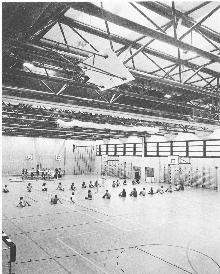
Blick von der Zuschauergalerie in die Sporthalle. Sämtliche Geräte und die Lüftung sind frei sichtbar in die offenen Fachwerkträger integriert
