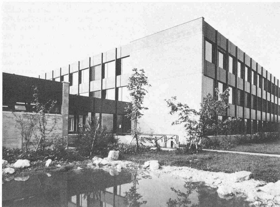
Nordwestecke des Klassentraktes mit Verbindungsteil zur Sporthalle
